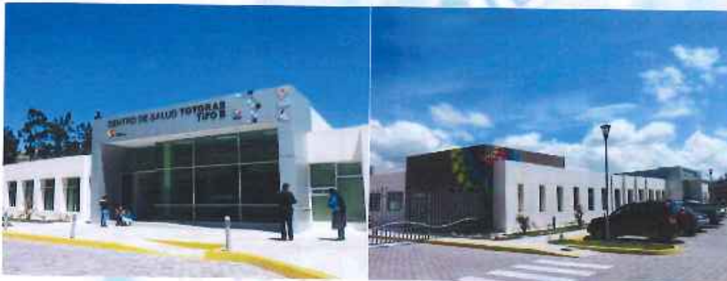
FIGURA 7 Instalaciones de Salud parroquia Totoras
